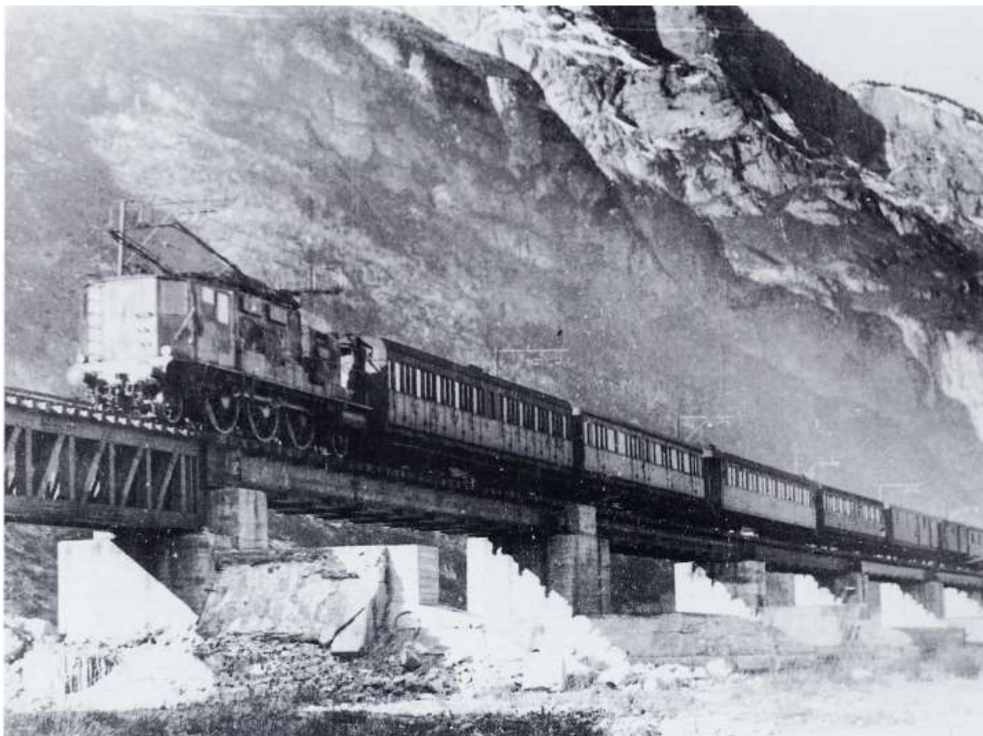
Viadotto dell'Avisio fine guerra: uno dei primi treni passeggeri trainato dalla locomotiva E 333 alimentata con energia elettrica trifase transita sull'unico binario di destra del manufatto ripristinato provvisoriamente dai danni subiti durante i numerosi bombardamenti aerei
