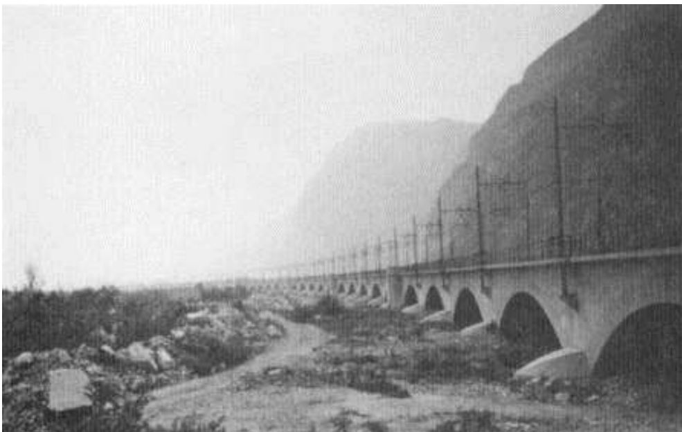
Viadotto ferroviario Avisio nel 1940 con i caratteristici rostri in conci di pietra per aumentare la stabilità
