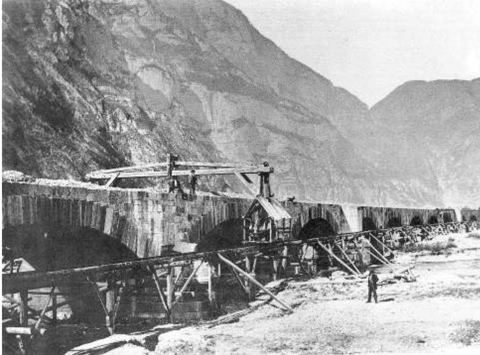
Ponte ferroviario sull'Avisio (ponte dei Vodi) in costruzione nell'anno 1858. Notare la primordiale gru a carro-ponte scorrevole sui binari sorretti da un ponteggio in legno
