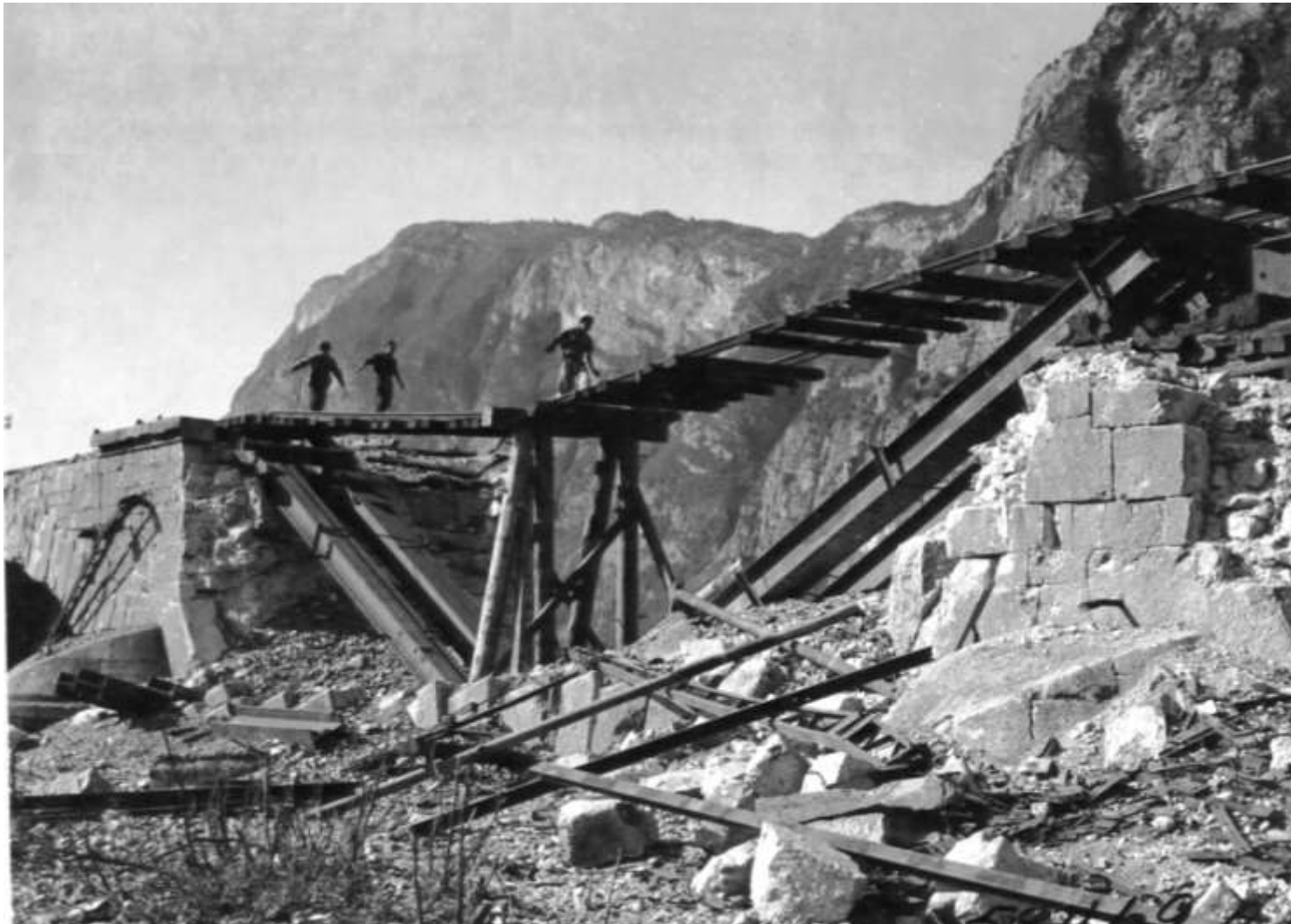
Maggio 1945: viadotto ferroviario Avisio funzionante con un solo binario distrutto dall'Aviazione americana. Notare l'arcata crollata e le due putrelle di sostegno divelte usate dal Genio ferroviario tedesco per rifare alcune arcate in calcestruzzo colpite dai numerosi bombardamenti nel 1944-45 (fonte www.fold3.com )
