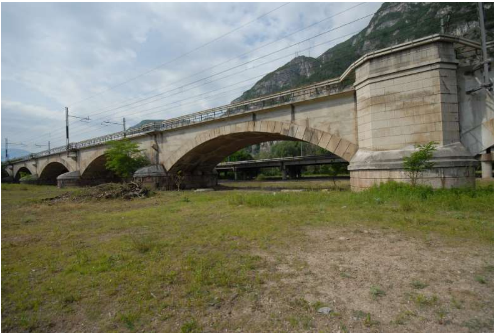
Viadotto ferroviario del torrente Avisio con tutte le arcate completamente ricostruite e con la nuova linea elettrica a corrente continua (foto 2012)
