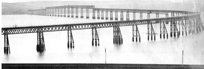
Ponte sul fiume Tay prima del crollo: al centro le campate poi crollate (Wikipedia Commons)
